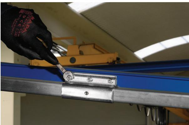
Unir dichos perfiles mediante el uso de los empalmes 2300/R-3-J que garantizan un recorrido continuo entre ambos tramos. Apretar los tornillos una vez que el empalme se haya situado en medio de ambos tramos de perfil. Repetir la misma operación para el resto de tramos de perfil.
