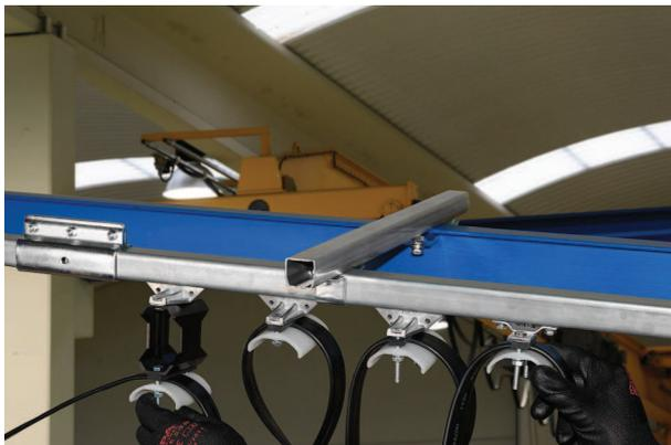
Insertar el sistema portacables en el perfil empezando primero por el carro arrastrador y siguiendo después por los carros intermedios. Introducir en último lugar el carro fijo.
