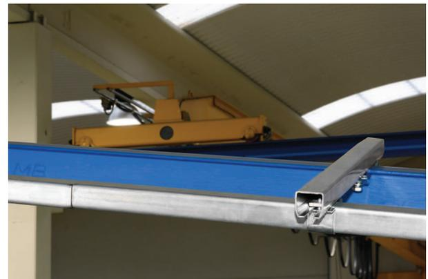
Montar el siguiente tramo de perfil en sus soportes 2300/R-4 correspondientes de la misma manera que el primero.
